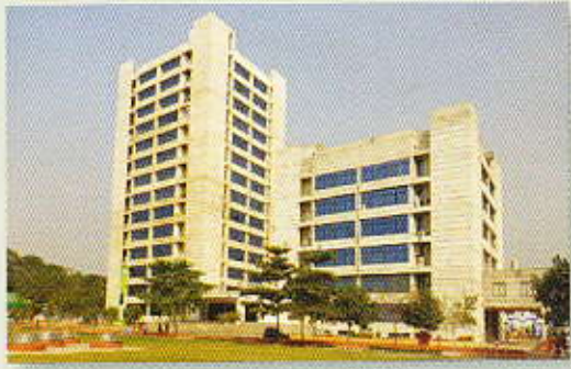
একাডেমিক ভবনের ৭ম -১৪ তম তলার উর্ধ্বমুখী সম্প্রসারণের কাজ
