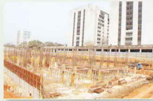
নির্মাণ কাজের অগ্রগতির চিত্র
