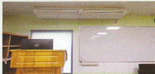
একাডেমিক ভবনের ৬ষ্ঠ হতে ৯ম তলায় মোট ১৬টি ক্লাশ রুমের জন্য আইসিটি সুবিধাসহ এসি স্থাপন
