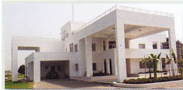
বিইউপি'র ভিসি'র বাংলা কাম অফিস ভবনের চলমান নির্মাণ কাজ
