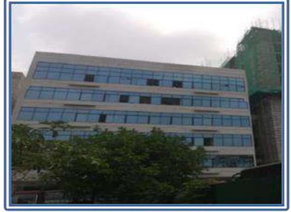
এফবিএস টাওয়ারের সাথে নির্মাণাধীন অডিটোরিয়াম
