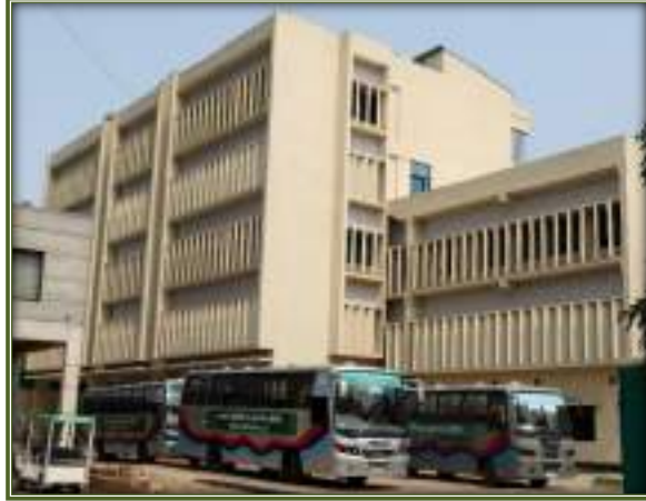
স্টাফ ডরমেটোরি কাম পার্কিং ভবন (নির্মাণ কাজ সম্পন্ন হয়েছে)
