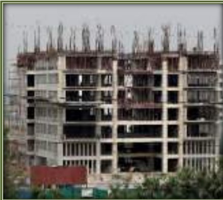
পশ্চিম ক্যাম্পাসে এফএসটি ভবন নির্মাণের কাজ চলমান
